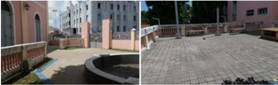
Figura 15 – Portão de acesso e pátio interno.
