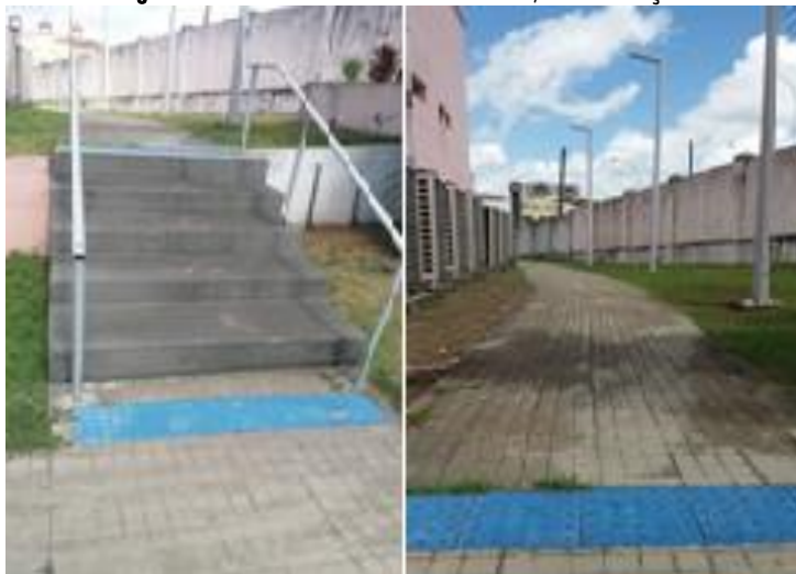
Figura 11 – Acesso lateral ao estacionamento, escada e calçada
