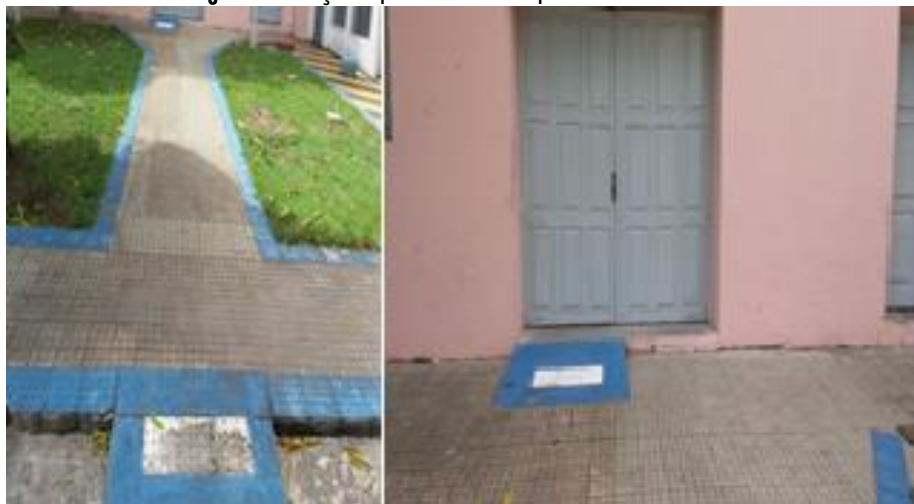
Figura 13 – Calçada e porta de acesso na parte de trás do teatro.
