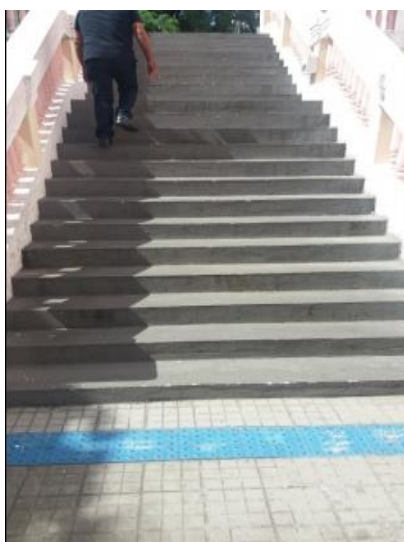
Figura 9 - Escada de Acesso a Administração
